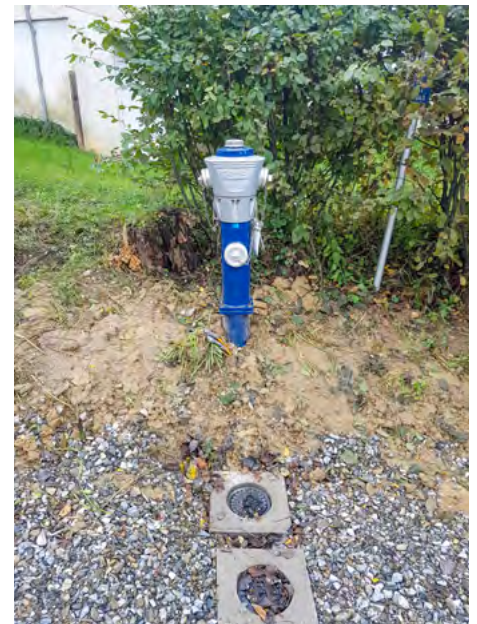
Zur besseren Löschwasserversorgung wurde auch in der Ortsmitte von Oberrettenbach ein neuer Hydrant versetzt.
