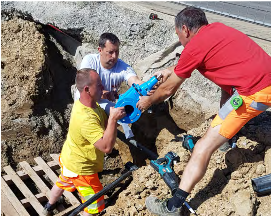
Zur besseren Löschwasserversorgung wurde auch in der Ortsmitte von Oberrettenbach ein neuer Hydrant versetzt.
