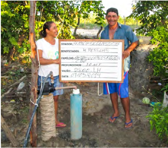
Zwei Brunnen wurden auch mit Spendengeldern der Gemeinde Gersdorf errichtet.
