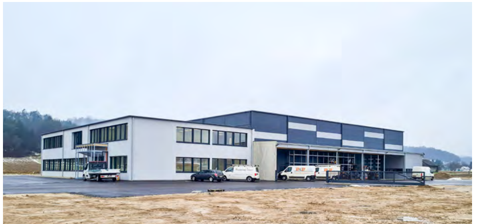
Das neue Betriebsgebäude mit Büro- und Sozialräumen sowie der Fertigungshalle
